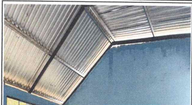
Foto 2: Sustitución de estructura portante en aulas
