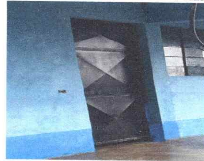
Foto 4: Sustitución de puertas de maderas a metal
