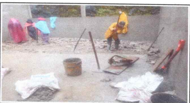
Foto 6: Sustitución de torta de cemento, por piso de cemento líquido
