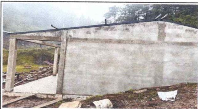
Foto 3: Sustitución de estructura portante en aulas
