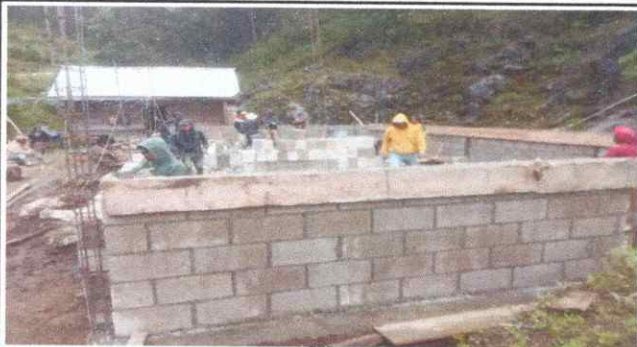
Foto 1: Mejoramiento de pared de tablas de madera por block
