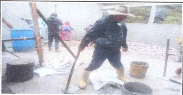
Foto 5: Sustitución de torta de cemento, por piso de cemento líquido
