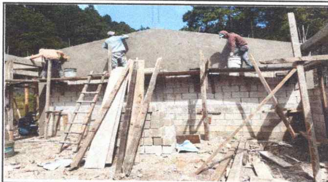
Foto 2: Mejoramiento de pared de tablas de madera por block
