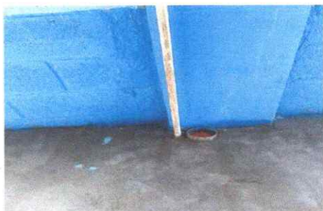
Foto 7: En la fotografía se puede observar que se repararon las tuberías PVC línea principal de aguas.
