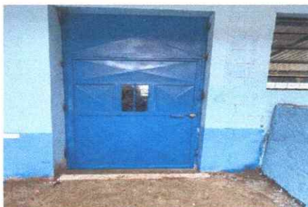
Foto 3: En la fotografía se puede observar que se cambió la puerta de madera por metal para una mejor seguridad en la cocina.
