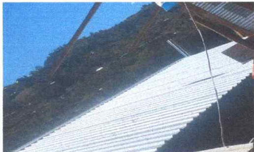
Foto 1: En la fotografía se puede observar que se cambió la lamina con agujeros para una mejor condición de uso de la cocina.
