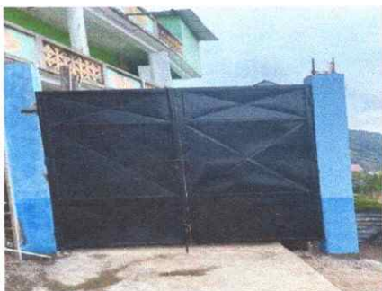
Foto 9: En la fotografía se puede observar que se instaló el portón de entrada principal del centro educativo.
