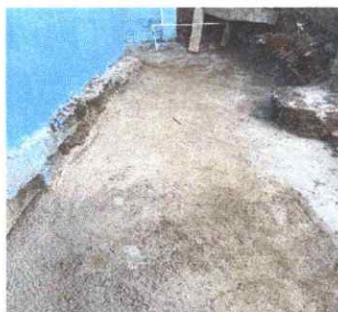
Foto 12: En la fotografía se puede observar que se reparó la cuneta en mal estado para que fluya el agua y evitar inundaciones.
