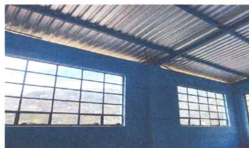
Foto 4: En la fotografía se puede observar que se cambiaron las ventanas de madera para una mejor ventilación y proyección de luz solar.
