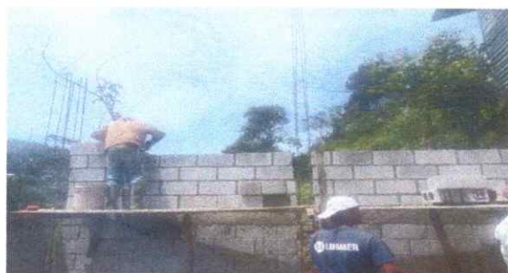
Foto 11: En la fotografía se observa que se están reparando las paredes con columnas y vigas para una mejor seguridad e higiene en la cocina.
