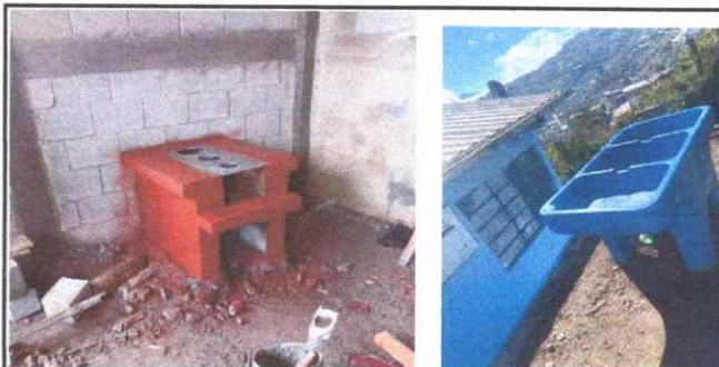
Foto 10: En la fotografía se observa que se está mejorando la cocina completa con estufa tradicional y sustitución de pila de dos lavaderos.
