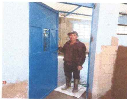
Foto 3: En la fotografía se observa que se está cambiando la puerta principal de la cocina.
