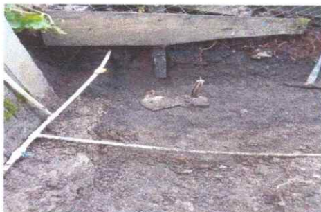
Foto 7: En la fotografía se observa que se están cambiando las tuberías PVC lineal principal de aguas.
