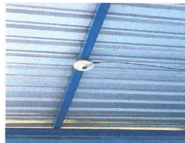
Foto 8: En la fotografía se observa que se está mejorando el sistema eléctrico para una mejor iluminación y conexión.
