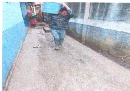
Foto 12: En la fotografía se observa que se está mejorando la cuneta para que fluya el agua y evitar accidentes.
