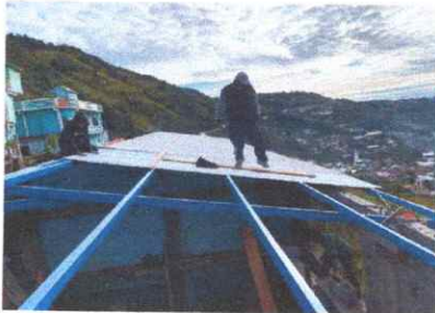
Foto1: En la fotografía se observa que se está cambiando la lamina con agujeros para una mejor condición de uso de la cocina.
