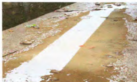
Foto 12: Reparación de cuneta en mal estado para que fluya el agua y evitar inundaciones.
