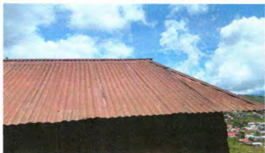
Foto 1: Cambio de lamina deteriorada con agujeros en el techo de la cocina, para una mejor condicon de uso y resguardo de los utensilios de cocina.
