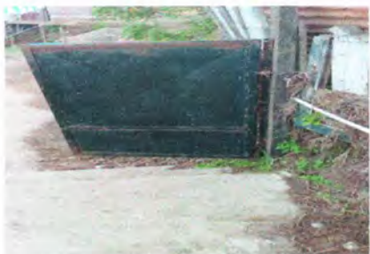
Foto 9: Fabricación e instalación de portón de metal de ingreso 175x2m.
