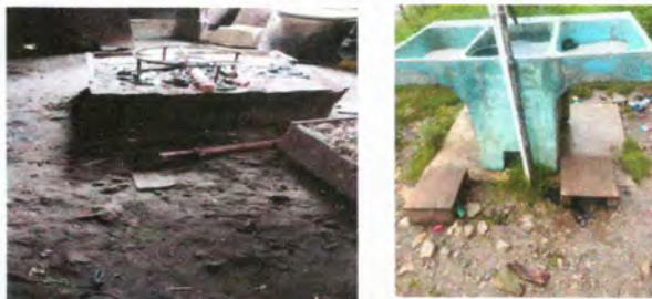
Foto 10: Reparación de cocina completa con estufa tradicional y sustitución de pila plástica de dos lavaderos.
