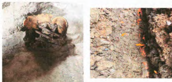
Foto 7: Sustitución de reposadera y tubería PVC línea principal de aguas.
