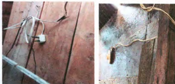
Foto 8: Reparación de sistema eléctrico para una buena iluminación y conexiones de distintos dispositivos electrónicos.
