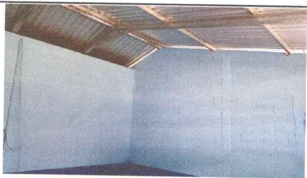
Foto 3: Parte Interior del establecimiento con estructura y sustitución de techo.
