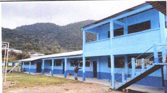
Foto1: Finalización del proyecto; una vista por parte de frente.
