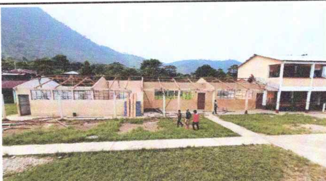
Foto 3: Retirada de la estructura de madera por metal
