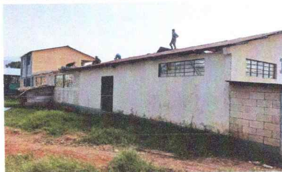
Foto 2: Retiro de laminas por troqueladas en la parte posterior del establecimiento.
