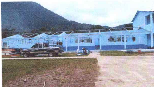
Foto 5: Colocación de la nueva estructura.
