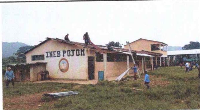
Foto 1: Retirada de la cubierta del establecimiento.
