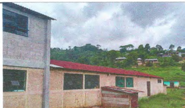
Foto 4: Parte sur del establecimiento donde se observa el techo y estructura de madera.
