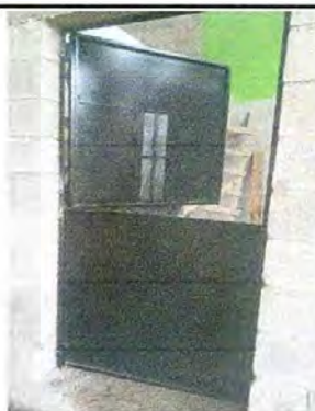
Foto 3: Sustitución de puertas, finalizado.
