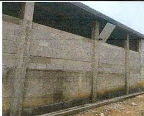
Foto 8: Reparación de paredes, finalizado
