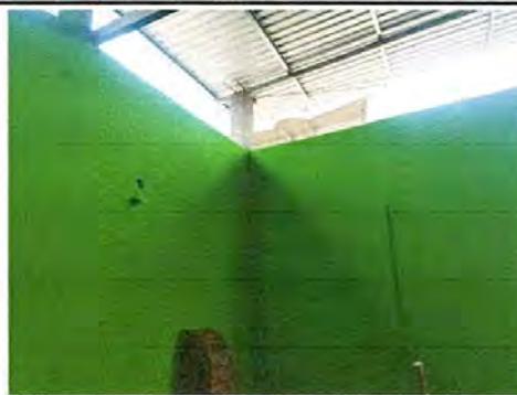
Foto 6: Pintado de paredes, finalizado
