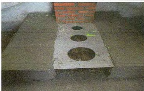
Foto 9: Sustitución de plancha de tres hornillas, finalizado.
