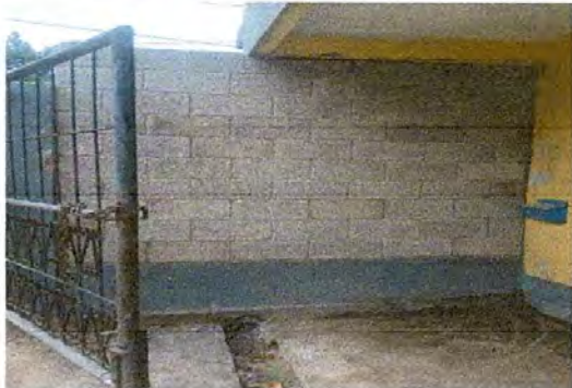
Foto7: Sustitución de bardas de metal por blok, finalizado.
