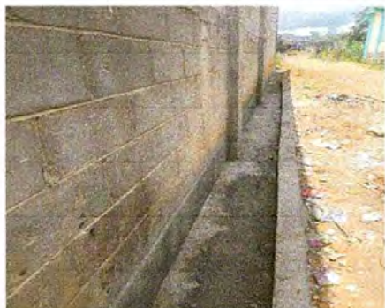
Foto 5: Reparación de cuneta de concreto, finalizado.
