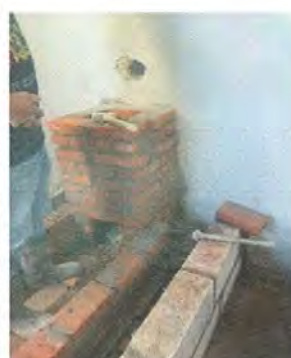
Foto 10: Debido al espacio se cambió la posición de la chimenea.
