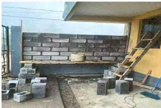
Foto 7: Se eliminó la barda de metal y se está sustituyendo por pared de blok..
