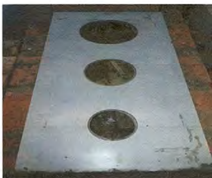
Foto 9: Se está colocando la nueva plancha.
