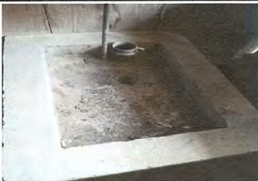
Se deberá de sustituir este labadero por una pila de Plastico ya que no cuenta con depósito de agua. Cuando en el establecimiento no hay agua no se puede lavar los utensilios de cocina.
