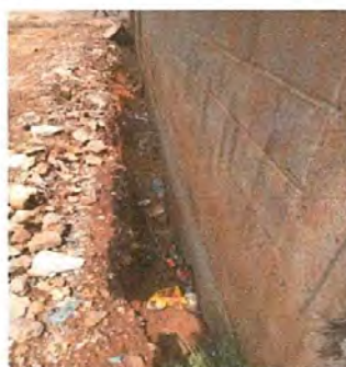
Foto 5: Existe una cuneta en la cual solo una parte es de concreto pero la otra parte solo es un sanjeado, lo cual hace que el agua filtre y se llena el patio de agua en épocas de lluvia.
