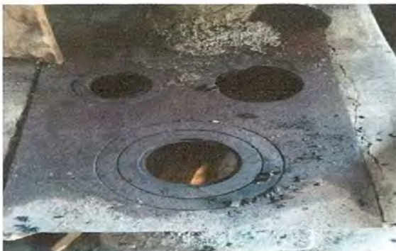
Foto 3: Se deberá cambiar la plancha por una nueva ya que está muy deteriorada.
