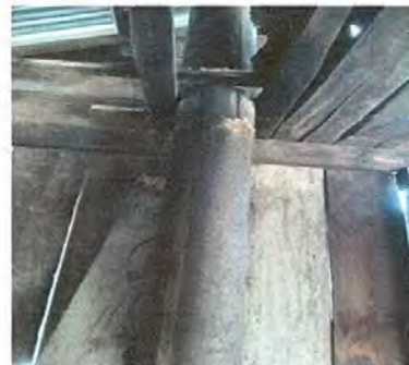
Foto 4: Debido al cambio de plancha de metal, se deberá cambiar también la chimenea con todo y la base para que pueda funcionar de una mejor manera
