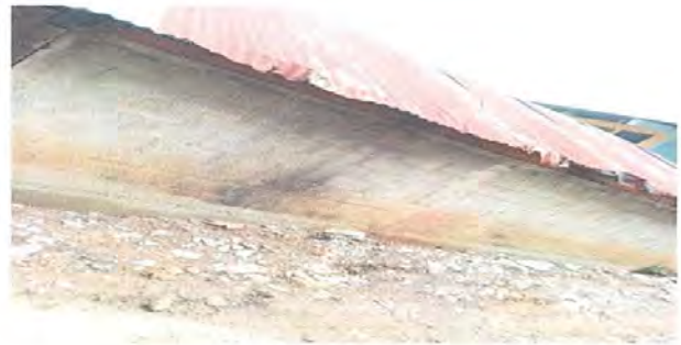
Foto 2: Es necesario continuar algunas iladas más de blok y colocarle corona de concreto a esta pared para que el techo quede más alto y de esa manera evitar que los carros pasen rozando la lámina.
