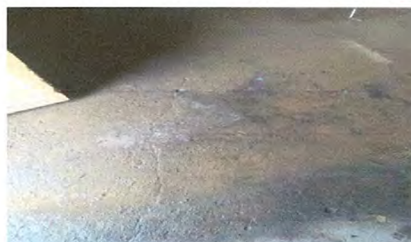
Foto 4: El piso de concreto tiene varias averturas por lo que es necesario repararla.
