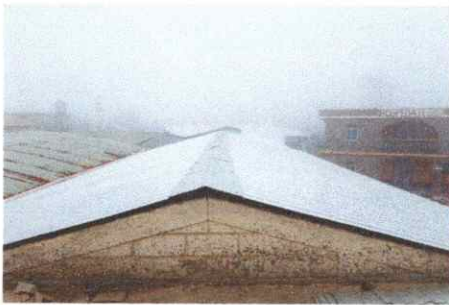
Foto 3: Techo intalado y finalizado
