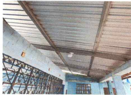
Foto 2: Finalizado la sustitución de estructura de soporte de metal
