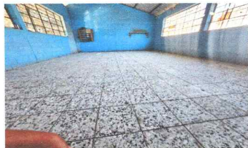
Foto 6: Piso granito en aulas finalizado
