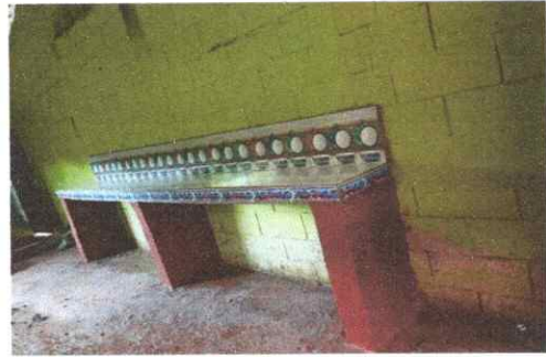
Foto 2: finalizado la puesta de azulejo
