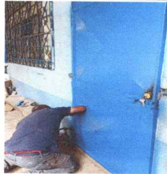
Foto 4: Puertas instaladas y finalizado
