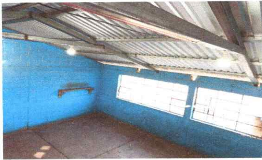
Foto 3: Sistema eléctrico instalado con calbe y focos ahorradores
