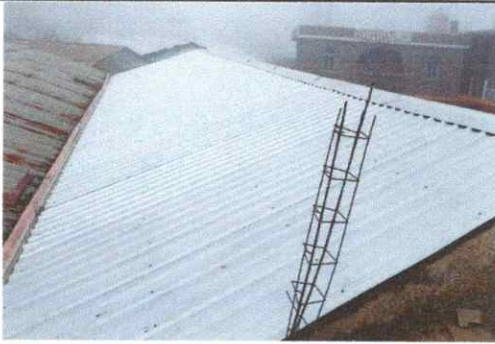
Foto1: Finalizado la intalación de lámina troquelada aluzinc calibre 26
