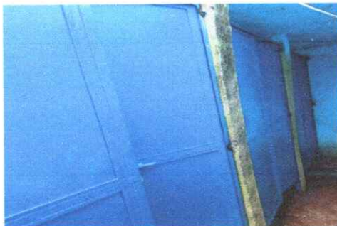
Foto 5: Puertas instaladas y finalizadas
