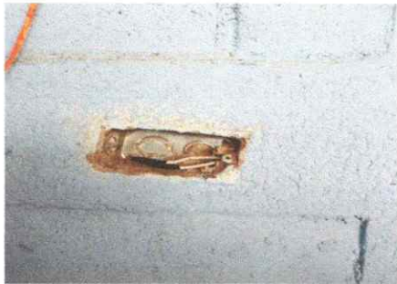
Foto 3: Sustitución de tomacorrientes en proceso
