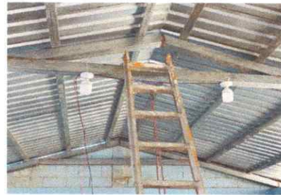
Foto 2: sustitución de focos en proceso
