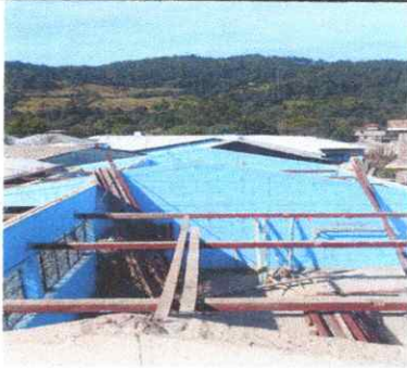
Foto 3: Sustitución de estructura de madera de soporte por metal en proceso de desmontaje
