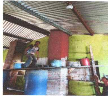
Foto 2: Reparación de estufa rural en proceso
