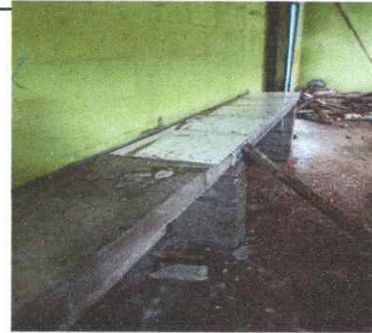
Foto 4: Reparación de estufas rurales en proceso
