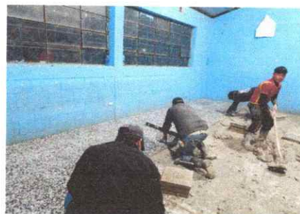
Foto 6: Sustitución de piso, por piso de granito en proce
