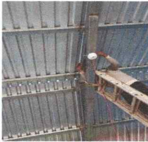
Foto1: Sustitución de intalación eléctrica en proceso
