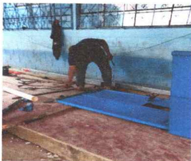
Foto 5: Sustitución de 4 puertas de madera en mal estado por puertas de metal, en proceso
