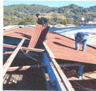
Foto 4: Sustitución de lámina por lámina troquelada aluzinc calibre 26. en proceso de desmontaje
