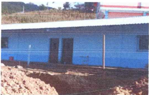
Foto1: Cambio de cubierta de lamina en el aula terminado
