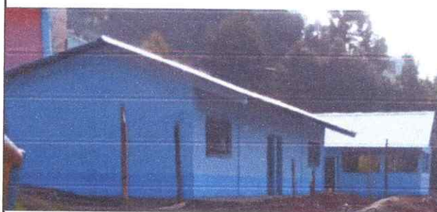
Foto 6: Aulas de la escuela y la cocina terminado
