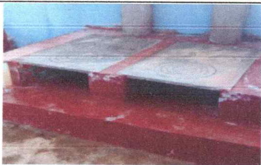
Foto 3: Cambio de reparacion de estufa rural de la cocina
