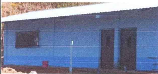
Foto 5: Cambio de pintura de balcones y puertas del aula.
