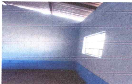
Foto 4: Pintadas de muros interiores y exteriores de aula
