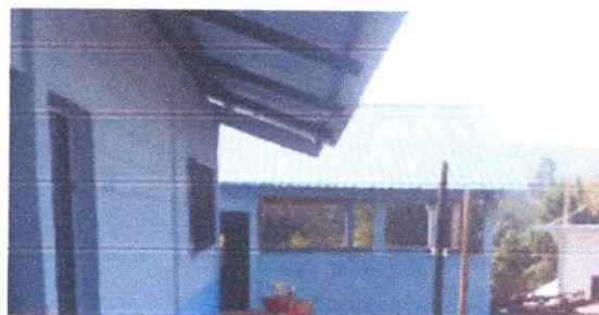
Foto 2: Cambio de estructura de techo para cocina terminado
