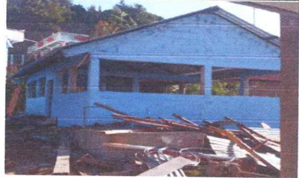
Foto 2: Cambio de estructura de techo para cocina
