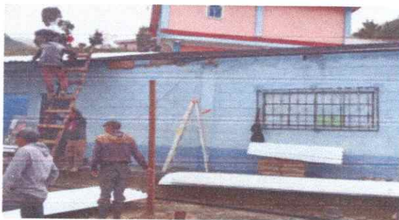
Foto 5: cambio de techo de aula
