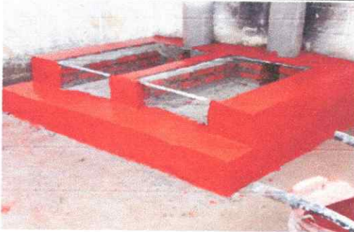
Foto 3: Cambio de reparacion de cocina
