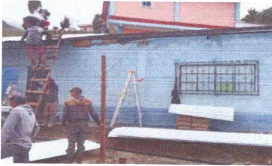
Foto1: Cambio de cubierta de lamina en el aula.
