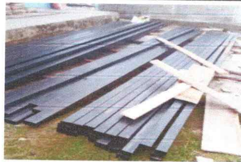
Foto 4: Tubos estructurales para el techo de aula
