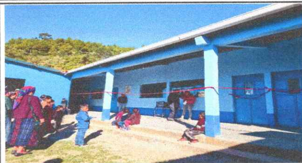
Foto7: se observa la pintura exterior e interior, en su totalidad y trabajo terminado
