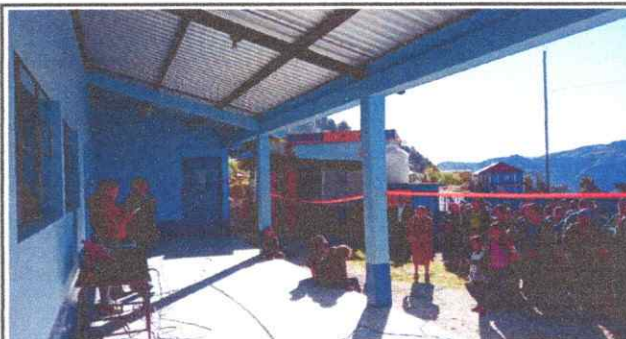
Foto: 10 en la imagen se observan los focos ya debidamente puestos y funcionando y trabajo terminado
