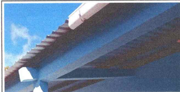
Foto 5: en la imagen se observa la colocación del canal de bajada de agua en PVC
