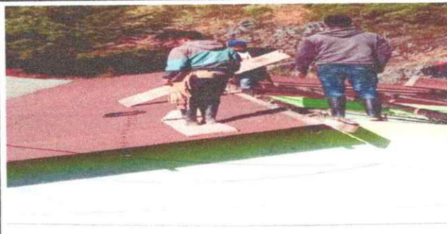
Foto 2: en la imagen se observan que se está haciendo el trabajo de levantar las laminas y capotes
