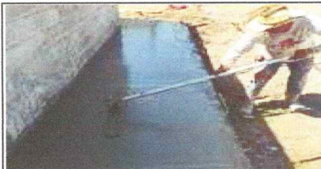
FOTO 6: en la imagen se observa el trabajo sobre la reparación de banqueta de concreto
