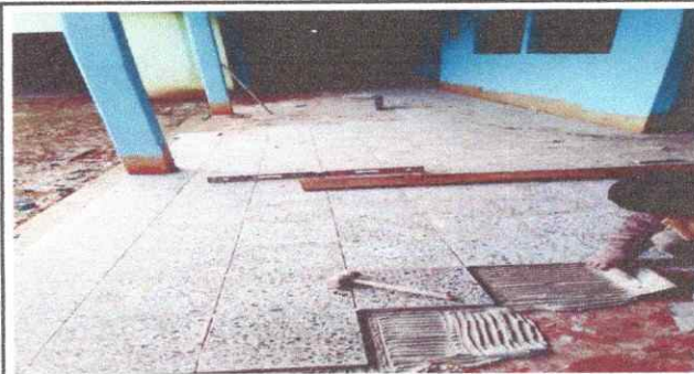
Foto 4: se puede observar en la imagen que se está realizando el trabajo correspondiente de la colocación del piso de granito
