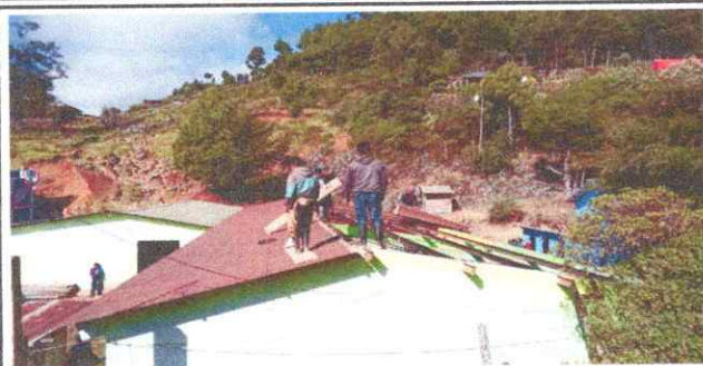
Foto 1: en esta imagen se observa que se están levantando las lamas
