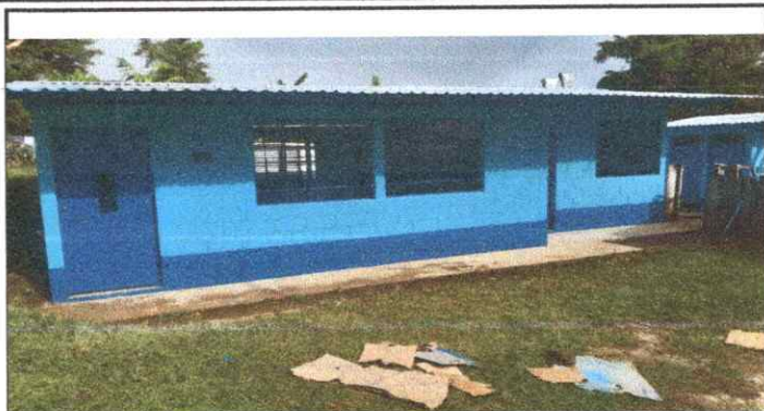
Foto 7 : Pintura en muros exteriores e interiores
