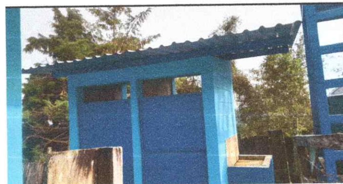
Foto 4: Sustitución de puerta en servicios sanitarios
