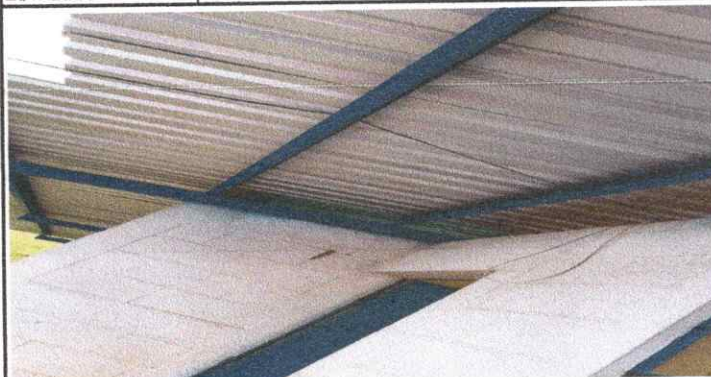
Foto 1: Mantenimiento a estructura de soporte de metal
