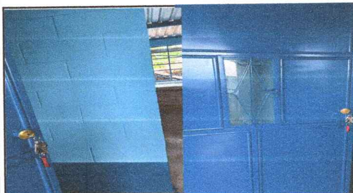
Foto 3: Sustitución de puerta
