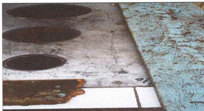
Foto 9: Sustitución de plancha de metal de 3 hornillas
