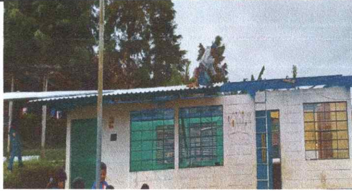
Foto 1: Mantenimiento a estructura de soporte de metal
