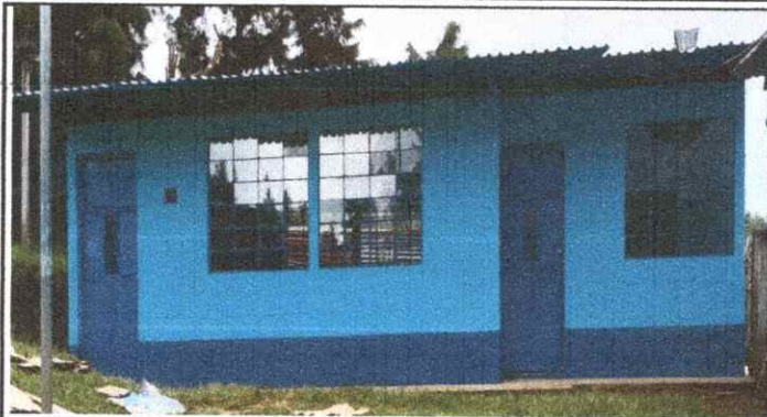
Foto 7 : Pintura en muros exteriores e interiores
