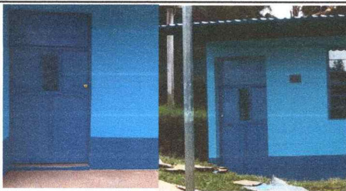
Foto 3: Sustitución de puerta
