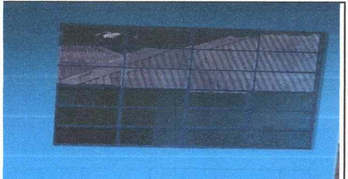
Foto 6: Sustitución de estructura de metal de ventana
