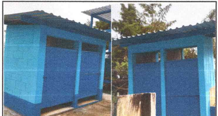
Foto 4: Sustitución de puerta en servicios sanitarios
