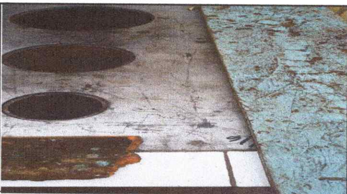
Foto 9: Sustitución de plancha de metal de 3 hornillas
