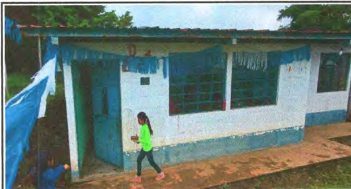
Foto 7 : Pintura en muros exteriores e interiores
