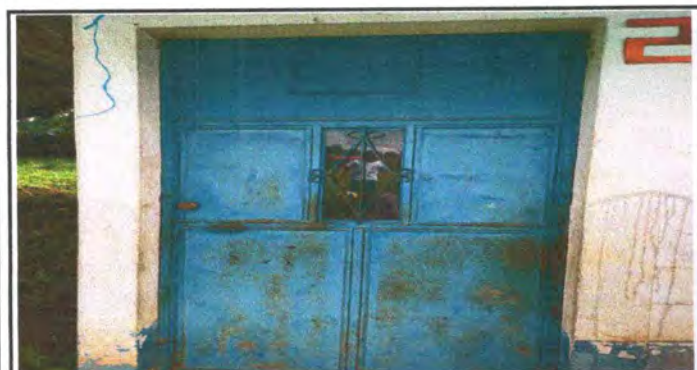
Foto 3: Sustitución de puerta
