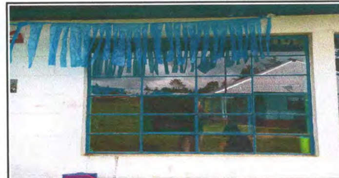
Foto 6: Sustitución de estructura de metal de ventana
