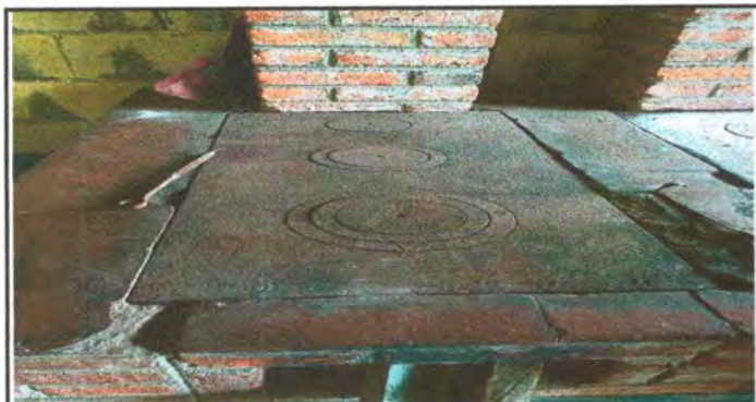
Foto 9: Sustitución de plancha de metal de 3 hornillas
