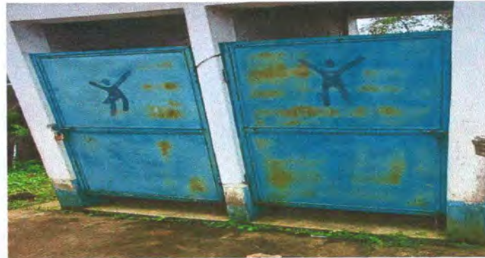
Foto 4: Sustitución de puerta en servicios sanitarios
