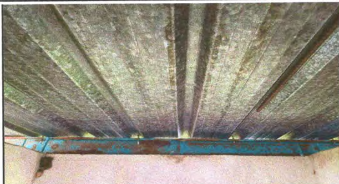
Foto 1: Mantenimiento a estructura de soporte de metal
