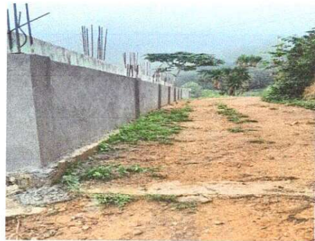
Foto 2: REPARACIÓN DE MURO PERIMETRAL DE BLOCK
