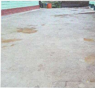
Foto 1: REPARACIÓN DE PISO DE TORTA DE CONCRETO
