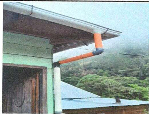
Foto 4: CANALES DE BAJADAS DE AGUA PLUVIAL
