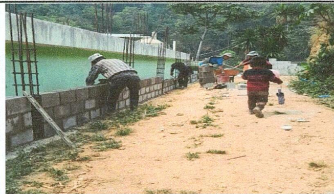
Foto 2: REPARACIÓN DE MURO PERIMETRAL DE BLOCK
