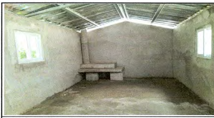
Foto 6: Sustitución de plancha y sustitución de chimenea a concreto. Sustitución de piso a torta de concreto en cocina finalizado.
