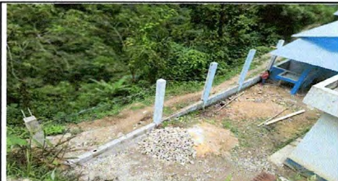
Foto 4: Reparación de muro perimetral de block con tubo hg y malla galvanizada, soleras intermedias y columnas finalizado.
