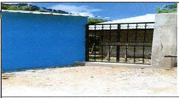
Foto 5: Fabricación e instalación de portón de metal de ingreso finalizado.
