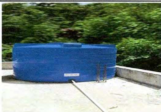
Foto 3: Sustitución depósito de agua finalizado
