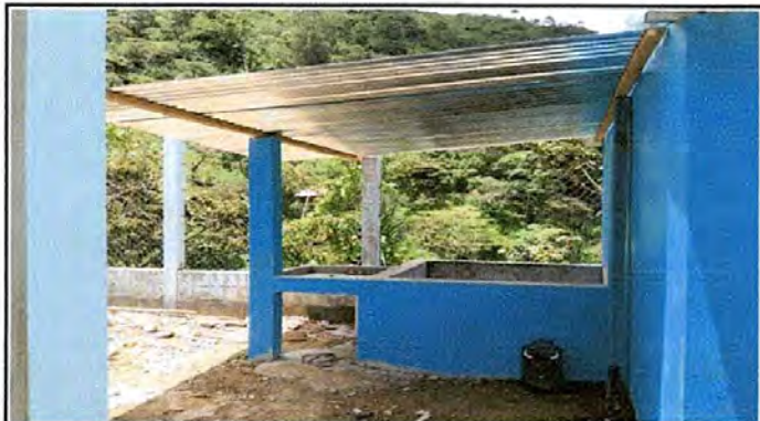
Foto 7: Sustrucción de pila finalizado.
