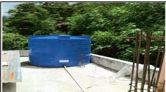
Foto 3: Sustitución depósito de agua en proceso.
