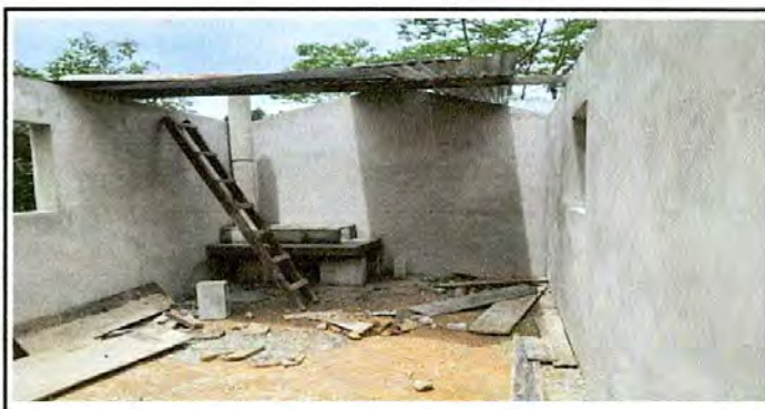
Foto 6: Sustitución de plancha y sustitución de chimenea a concreto. Sustitución de piso a torta de concreto en cocina en proceso.
