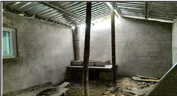
Foto 1: Cocina: sustitución de lámina en malas condiciones y sustitución de estructura de soporte tanto columnas y de techo madera a metal. Cambio de ventanas y de puerta en proceso.
