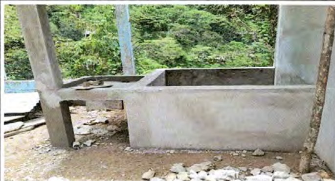
Foto 7: Sustrución de pila en proceso.
