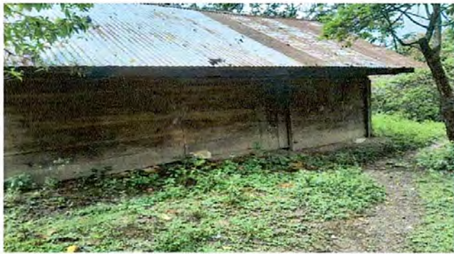
Foto 1: Cocina: sustitución de lámina en malas condiciones y sustitución de estructura de soporte tanto columnas y de techo madera a metal. Cambio de ventanas y de puerta.
