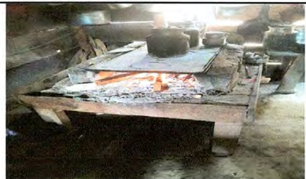
Foto 6: Sustitución de plancha y sustitución de chimenea a concreto. Sustitución de piso a torta de concreto en cocina.
