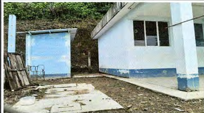
Foto 8: Repello de pared, pintura de pared exteriores e interiores.
