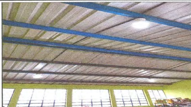
Foto 2: Sustitucion del Cableado Electrico
