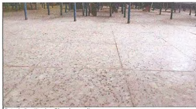
Foto 6: Sustitucion Piso de granito
