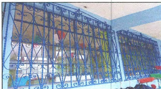
Foto 3: Balcones en Ventanas
