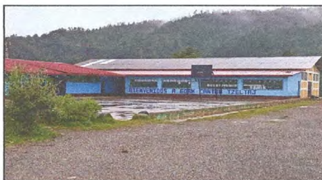
Foto 4: Pintura en exteriores
