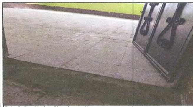
Foto 5: Sustitucion Piso de granito
