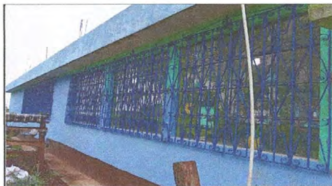
Foto 4: Balcones en Ventanas
