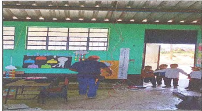
Foto 2: Reparacion de Cableado Electrico
