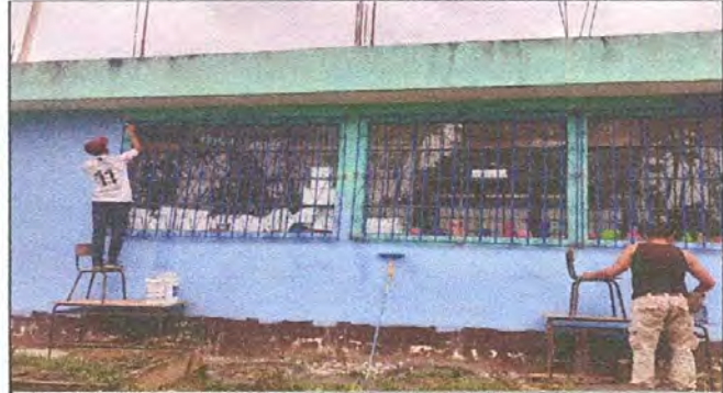
Foto 2: Aplicación de Pintura
