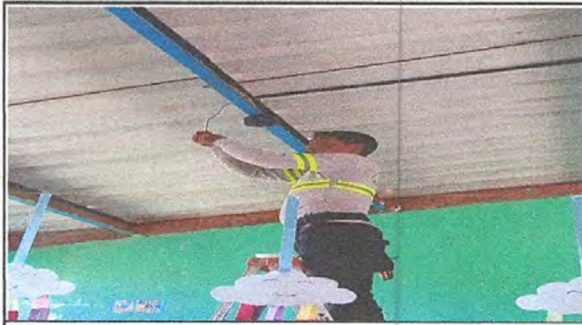
Foto1: Sustitucion de Plafoneras
