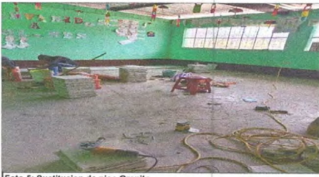
Foto 5: Sustitucion de piso Granito
