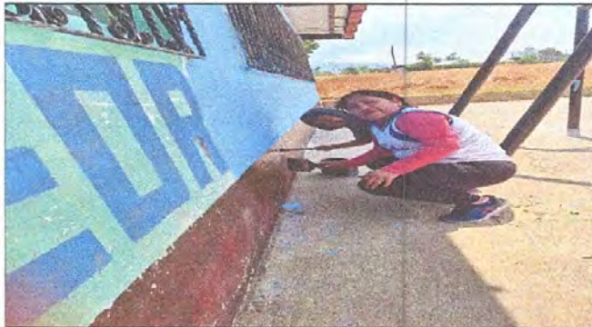
Foto 3: Aplicación de Pintura en Exteriores
