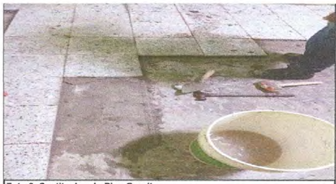
Foto 6: Sustitucion de Piso Granito
