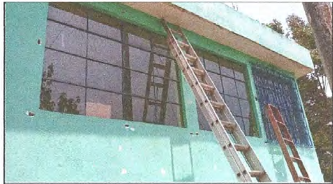
Foto 4: Instalacion de Balcones
