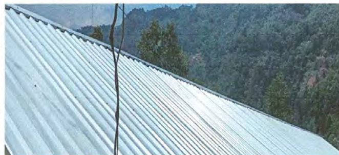
Foto 2: Sustitucion de capote de lamina para lamina troquelada
