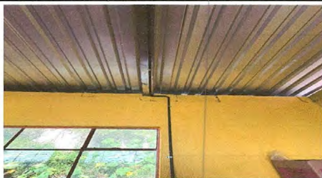
Foto 18: Reparacion de cableado electrico
