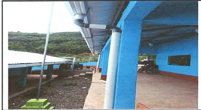
Foto 8: Reparacion de baja de agua pluvial tubo pvc 3
