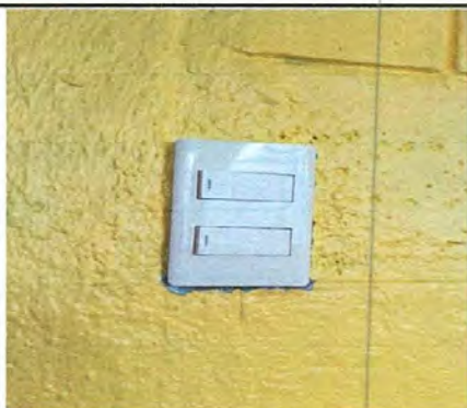
Foto 15: Sustrucion de interruptores dobles
