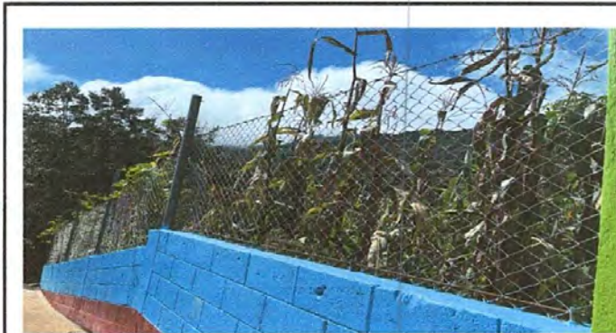
Foto 11: Reparacion de tubo HG y malla galvanizada
