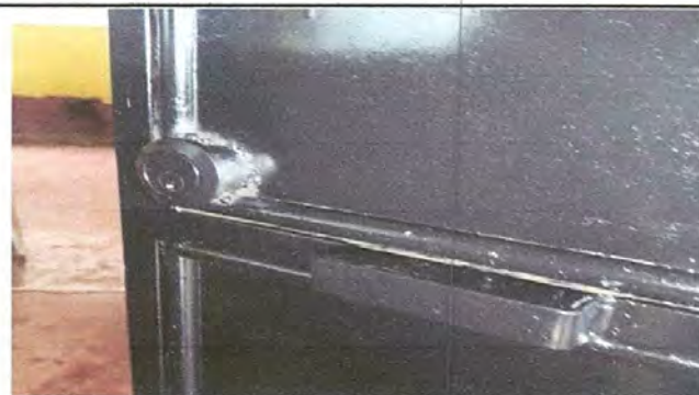
Foto 5: Sustitucion de chapa
