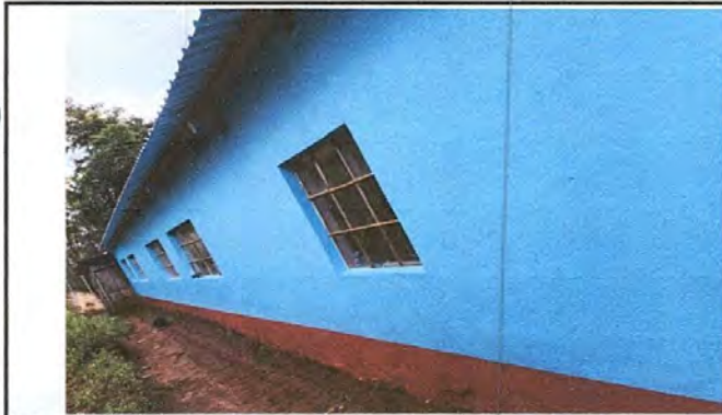
Foto 9: Pintura en muros exteriores e interiores
