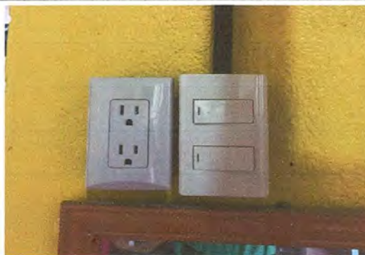
Foto 16: Sustrucion de tomacorrientes dobles
