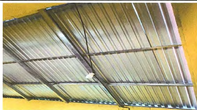
Foto 19: Sustrucion de ducto electrico + accesorios
