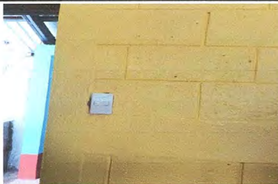
Foto 14: Sustrucion de interruptores simples
