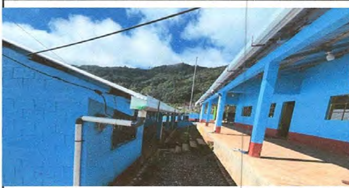
Foto 7: Sustrucion de canal de metal
