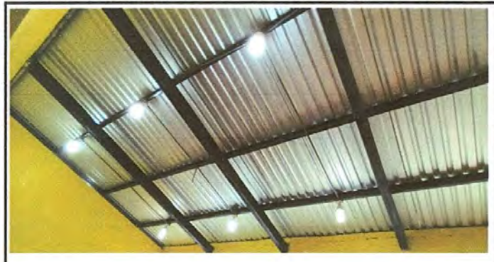
Foto 12: Sustrucion de lamparas tipo led
