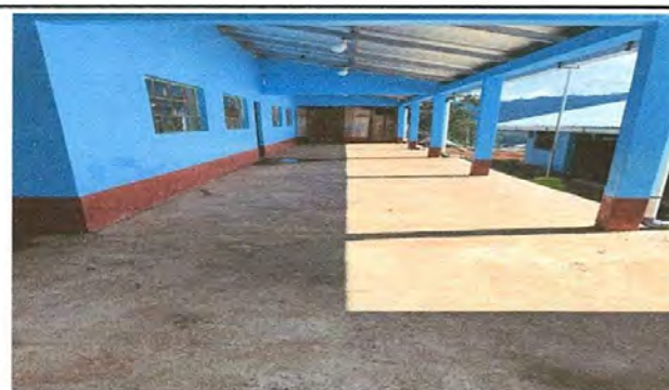
Foto 6: Sustitucion de piso de torta de concreto
