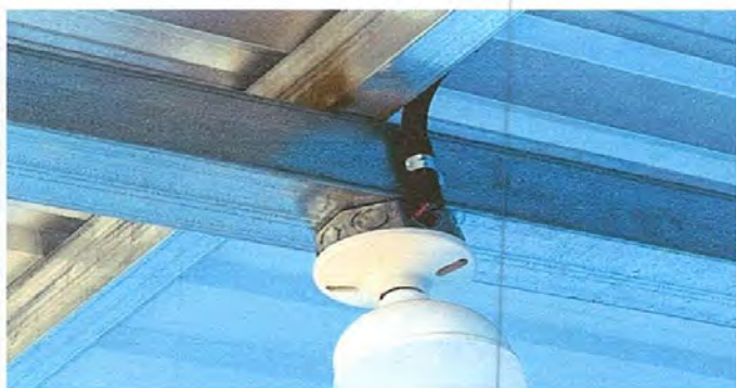
Foto 13: Sustrucion de plafoneras
