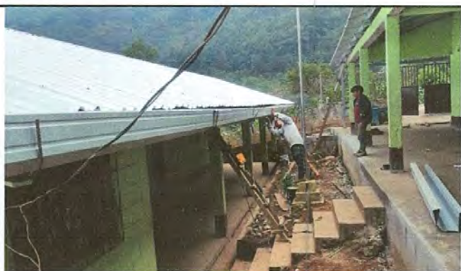
Foto 7: Sustitucion de canal de metal
