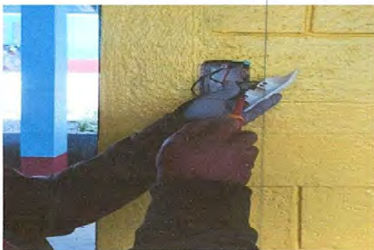
Foto 15: Sustitucion de interruptores dobles
