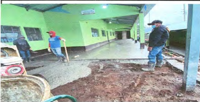
Foto 6: Sustitucion de piso de torta de concreto
