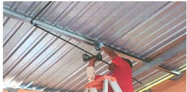
Foto 19: Sustitucion de ducto electrico + accesorios
