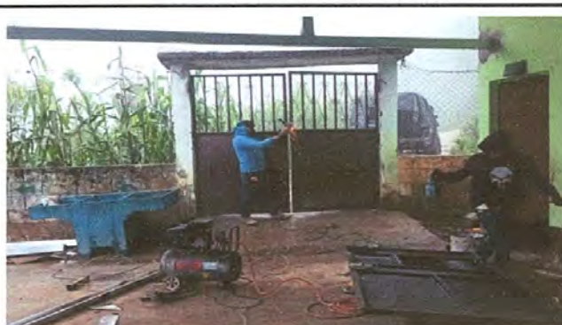
Foto 10: Mantenimiento a porton de metal
