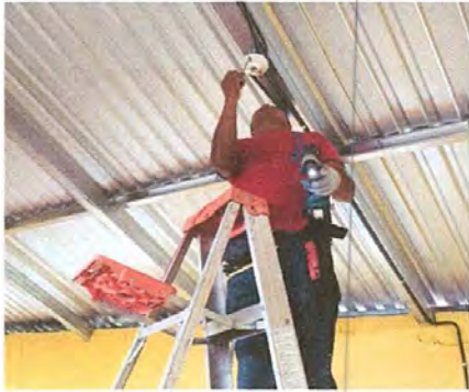
Foto 13: Sustitucion de plafoneras
