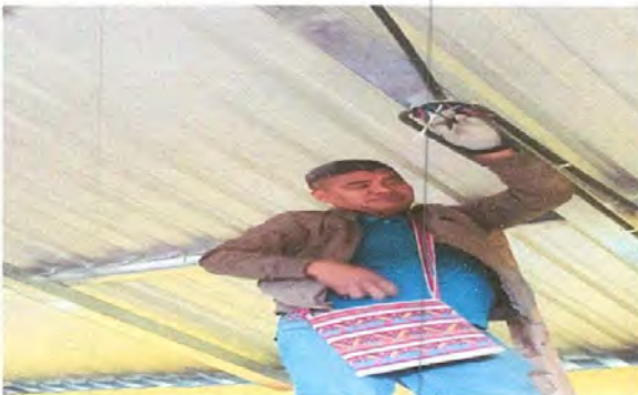
Foto 18: Reparacion de cableado electrico
