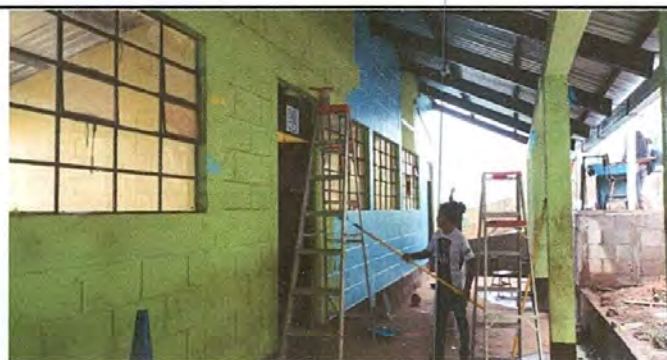
Foto 9: Pintura en muros exteriores e interiores
