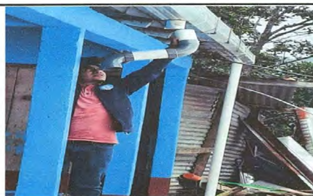
Foto 8: Reparacion de baja de agua pluvial tubo pvc 3
