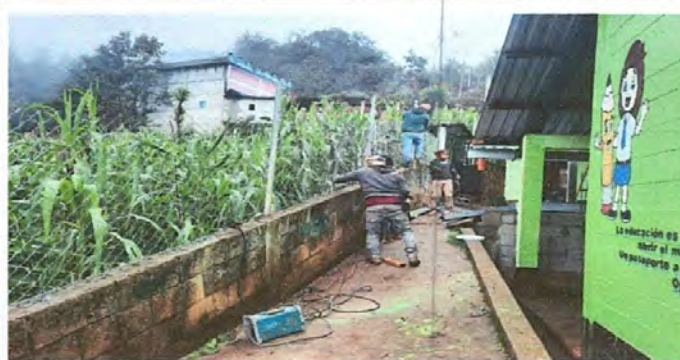
Foto 11: Reparacion de tubo HG y malla galvanizada
