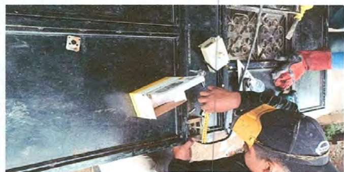
Foto 5: Sustitucion de chapa
