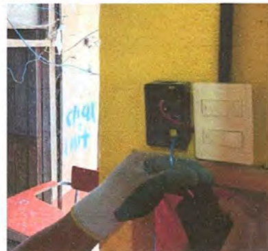
Foto 16: Sustitucion de tomacorrientes dobles
