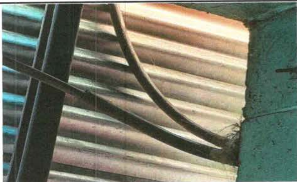
Foto 19: Sustitucion de ducto electrico + accesorios
