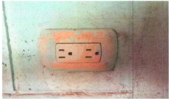
Foto 16: Sustrucion de tomacorrientes dobles
