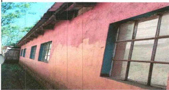
Foto 9: Pintura en muros exteriores e interiores
