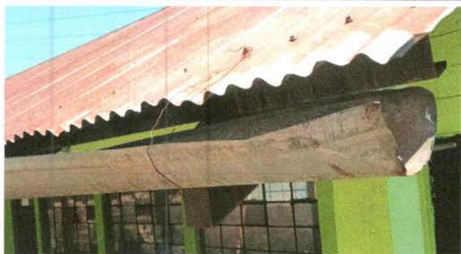
Foto 7: Sustrucion de canal de metal
