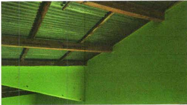
Foto 3: Sustitucion de estructura de soporte de madera por metalica
