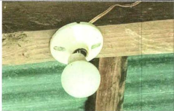
Foto 12: Sustrucion de lamparas tipo led
