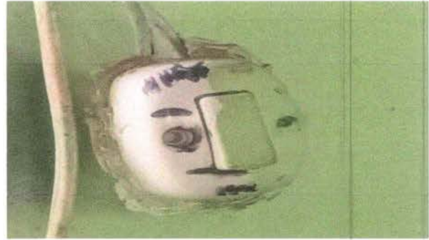
Foto 14: Sustrucion de interruptores simples
