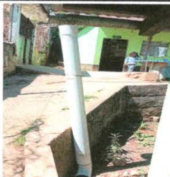
Foto 8: Reparacion de baja de agua pluvial tubo pvc 3
