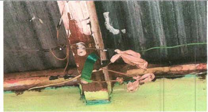
Foto 18: Reparacion de cableado electrico
