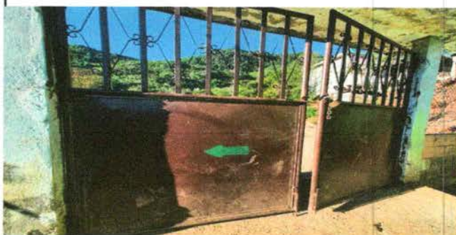
Foto 10: Mantenimiento a porton de metal
