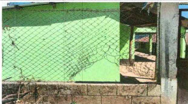
Foto 11: Reparacion de tubo HG y malla galvanizada
