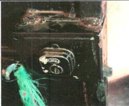
Foto 5: Sustitucion de chapa
