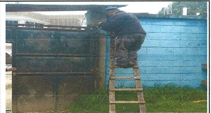
Foto 4: sustitución de portón
