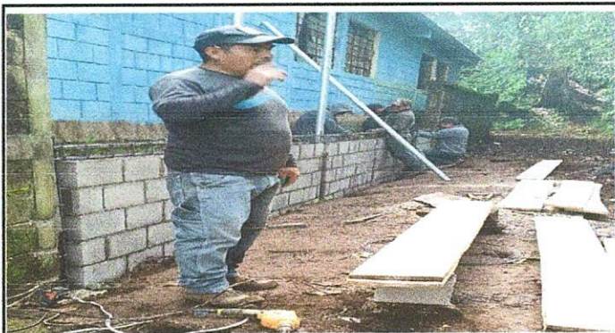
Foto 3: reparación de muro perimetral
