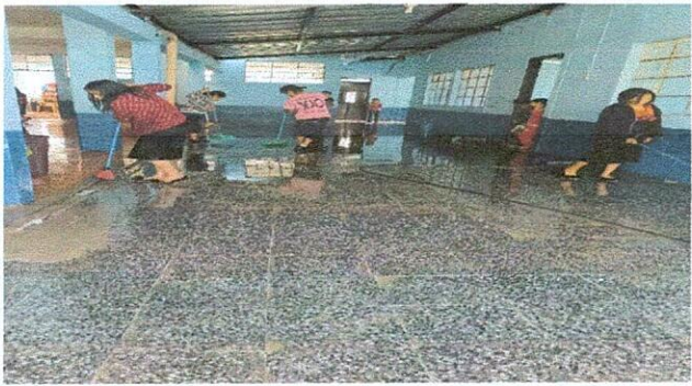
Foto1: SUSTITUCIUN DE PISOS
