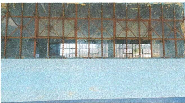
Foto 2: VIDRIOS DE VENTANA
