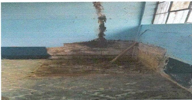
Foto 5: SUSTITUCIÓN DE PLANCHA DE LA COCINA
