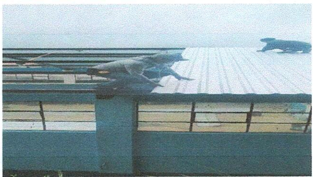
Foto 4: TECHO DEL SALON DE LA ESCUELA
