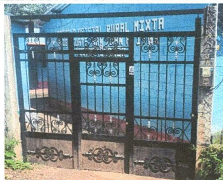
Foto 6: Sustitución de Portón informal por portón Metálico
