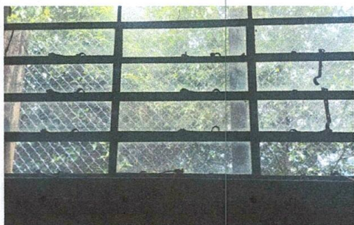
Foto1: Sustitución de vidrios
