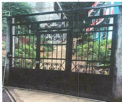
Foto 5: Sustitución de Portón informal por portón Metálico
