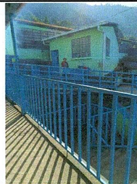
Foto 6: Pintura en puertas y barandas
