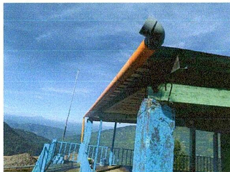
Foto 2: Sustitución de canales
