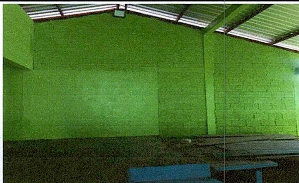
Foto 3: Reparación de muro perimetral
