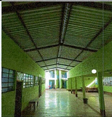
Foto1: Cambio de láminas
