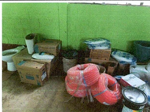
Foto 4: Cambio de sanitarios
