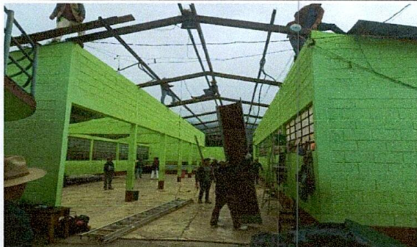
Foto1: Cambio de láminas
