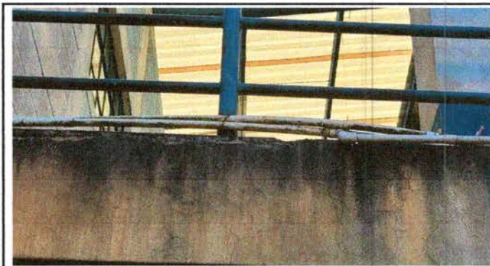
Foto 10: Sustitución de tubería línea principal
