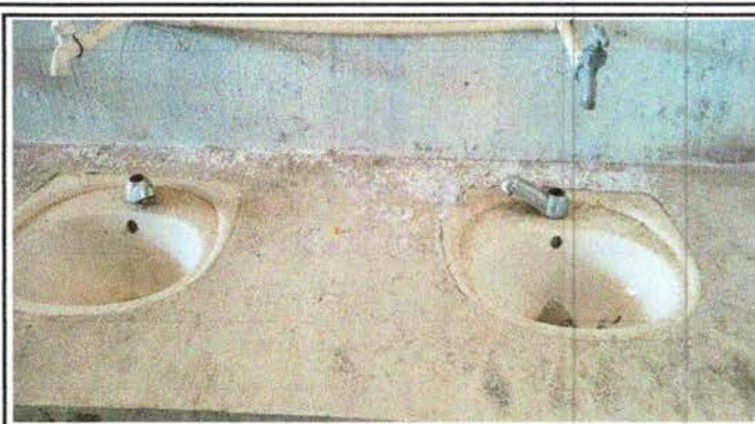
Foto 8: sustitución de grifos
