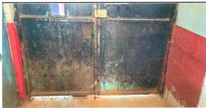
Foto 5: Sustitución de portón de metal
