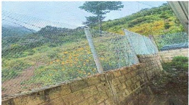
Foto 8: Sustitución de malla en muro perimetral
