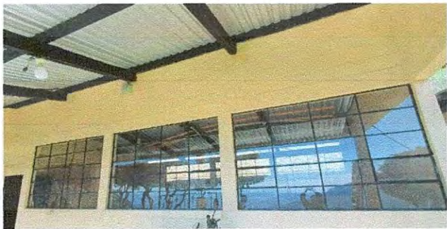
Foto 3: Mantenimiento a estructura de ventanas
