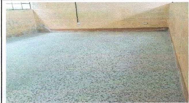
Foto1: Sustitución de piso en salones de clase y pasillos
