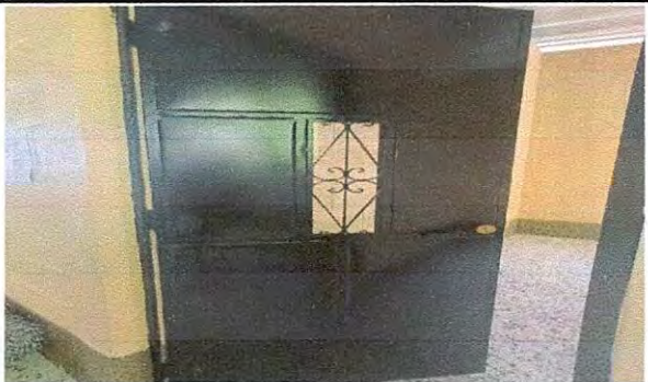
Foto 9: Mantenimiento a puertas
