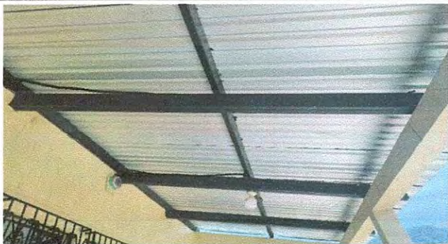
Foto 4: Mantenimiento de estructura de techo
