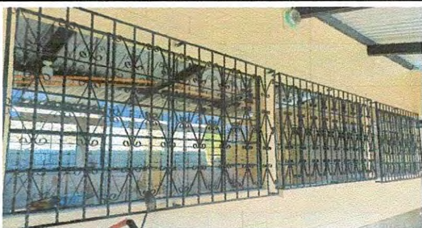
Foto 10: Colocación de balcones en ventanas
