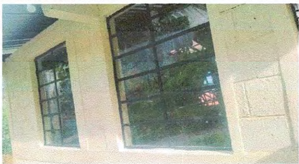
Foto 2: Sustitución de vidrios en ventanas
