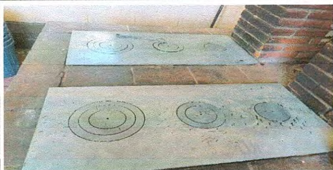
Foto 5: Sustitución de planchas
