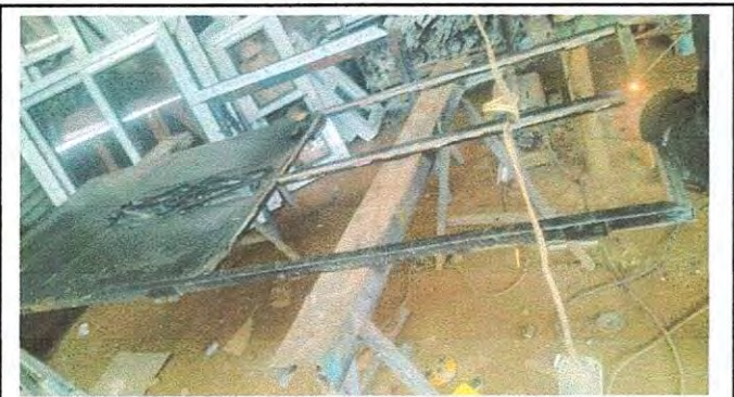
Foto 9: Mantenimiento a puertas
