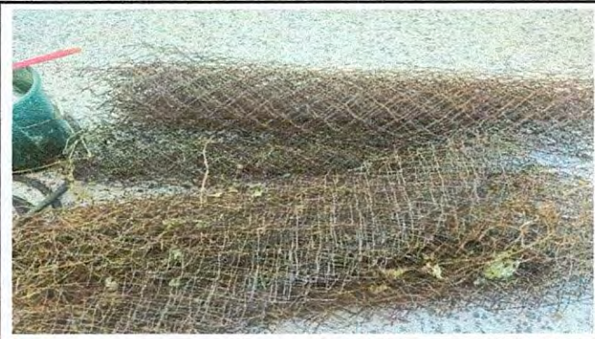
Foto 8: Sustitución de malla en muro perimetral
