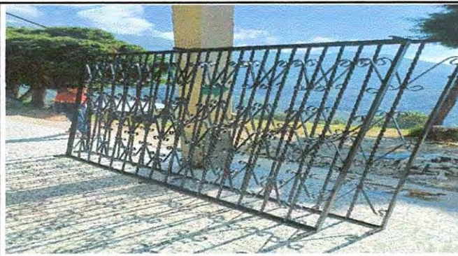
Foto 10: Colocación de balcones en ventanas
