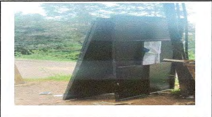
Foto 7: Sustitución de chapas
