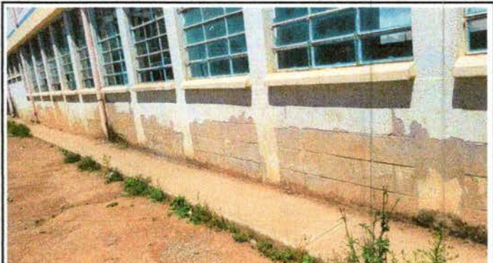
Foto 10: Repello en muros
