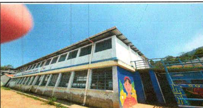
Foto 3: Pintura en muros exteriores e interiores
