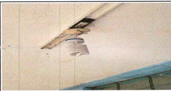
Foto 5: Sustitución de focos ahorradores
