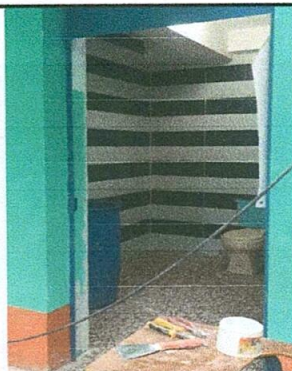
Aplicación completa de cerámica en baños
