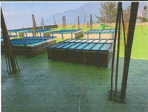
Impermeabilización terminada de techo
