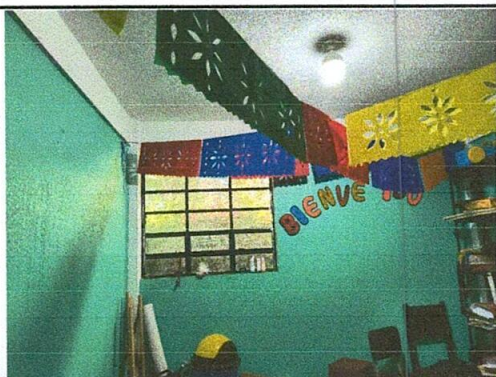
Aplicación completa de impermeabilización de interiores
