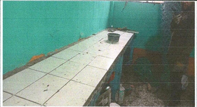
Colocacion de ceramica a plancha de cocina
