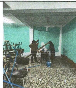
Aplicación de impermeabilizante y pintura de antimoho
