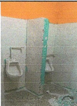
Remodelacion de baños y mingitorios
