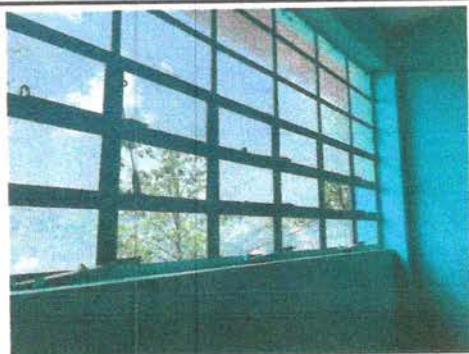
Mantenimiento de ventanas
