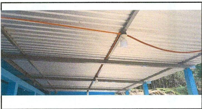
Foto 5: sustitución de estructura de madera por metal
