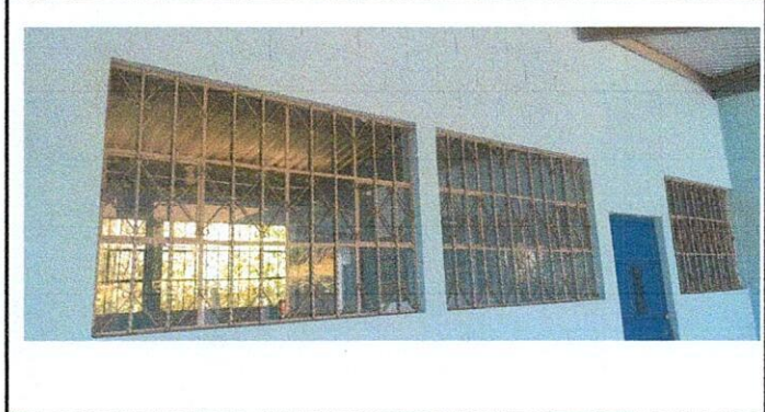
Foto 2: sustitucion de vidrios
