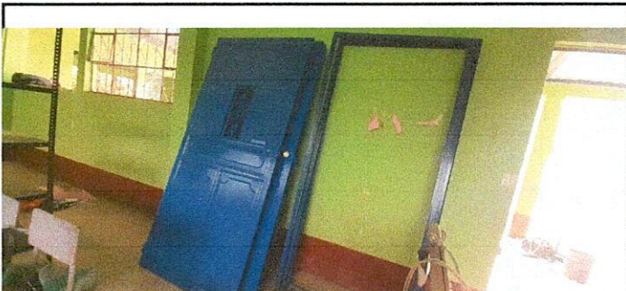
Foto 4: sustitucion de pueras
