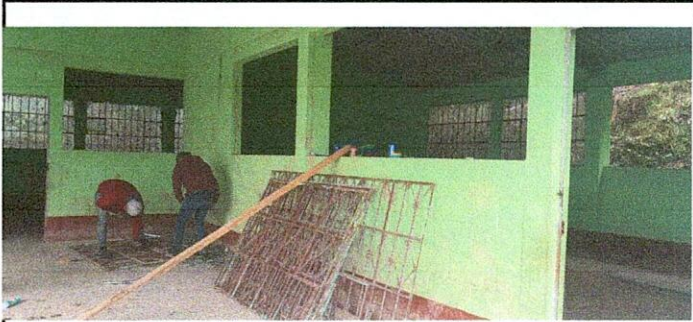
Foto 2: sustitucion de vidrios
