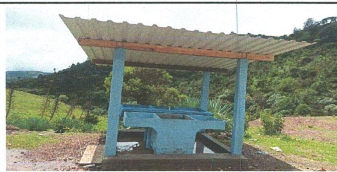
Colocación de pila nueva realizado
