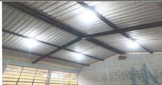
Colocación de foco de alumbrado eléctrico hecho
