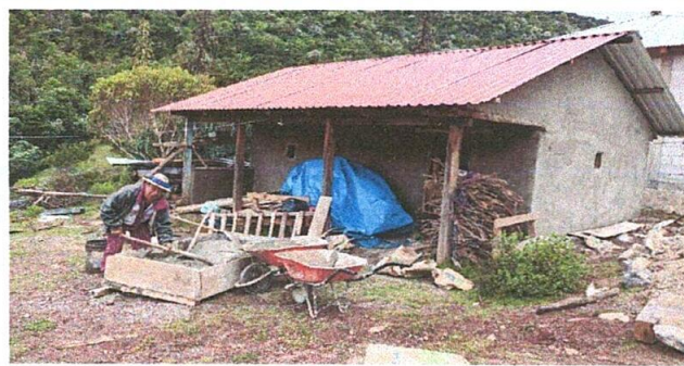
Mejoramiento de piso de cocina
