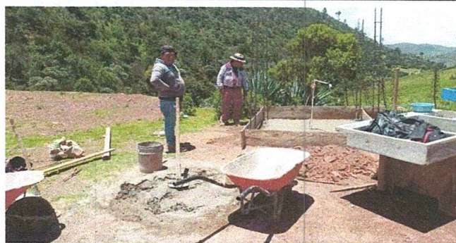
Mejoramiento de losa para colocación de pila
