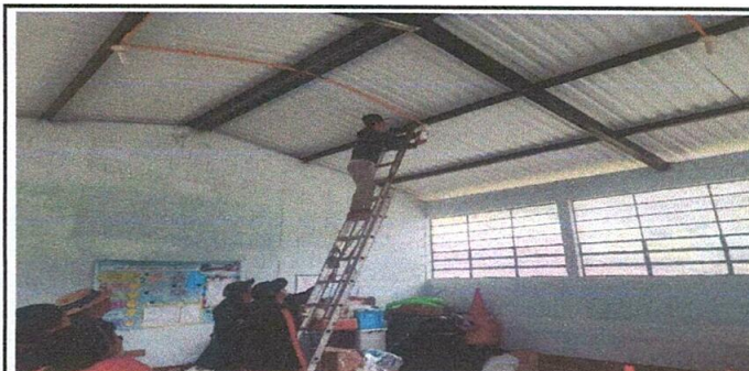
Cambio de focos de alumbrado eléctrico
