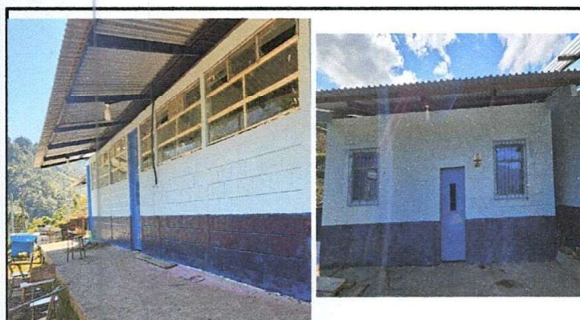
PINTURA EN MUROS EXTERIORES E INTERIORES
