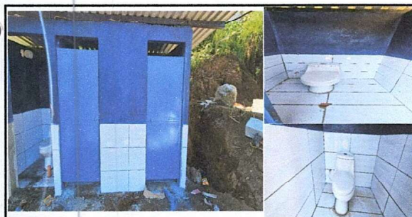
SERVICIOS SANITARIOS: Sustitución de inodoros, lavamanos y azulejo, Fabricación de puertas
