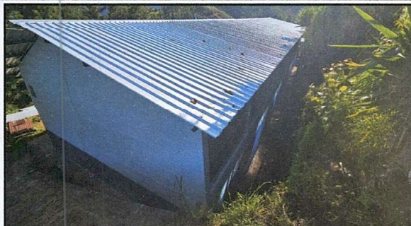
CUBIERTA DE TECHO: Sustitución de lámina por lámina troquelada, capote troquelada, elementos de fijación y Mantenimiento de estructura de metal
