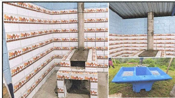
REPARACIÓN DE COCINA: , Reparación de azulejo de estufa rural, Sustitución de chimenea de concreto de estufa rural, Sustitución de pila de concreto
