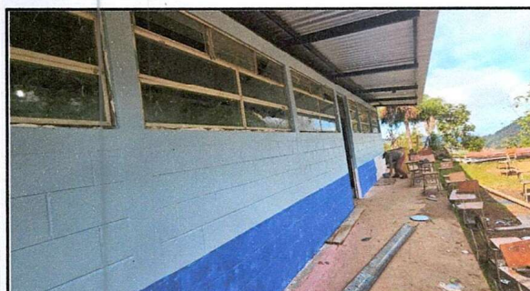
PINTURA EN MUROS EXTERIORES E INTERIORES
