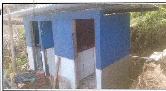
SERVICIOS SANITARIOS: Sustitución de inodoros, lavamanos y azulejo, Fabricación de puertas
