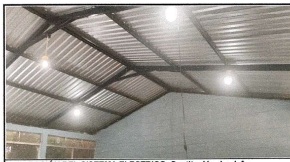
REPARACIÓN DEL SISTEMA ELECTRICO: Sustitución de plafoneras, focos ahorradores, tomacorrientes interruptores, cableado eléctrico, ducto eléctrico y sus accesorios
