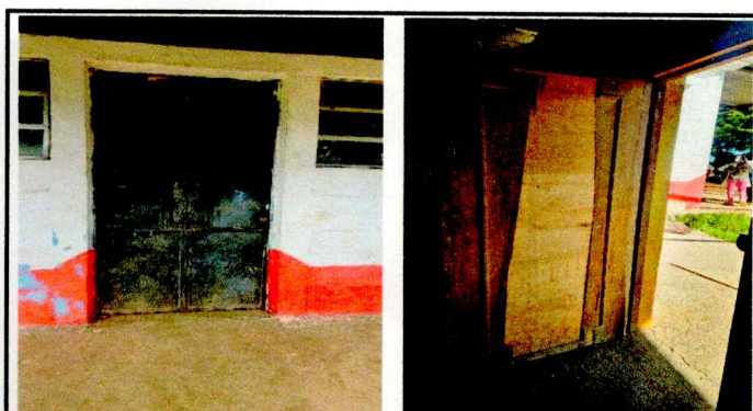
PUERTAS: Reparación de puertas de aula incluyendo pintura, Sustitución de puerta de acceso a cocina,
