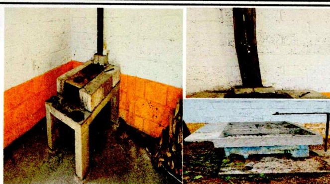
REPARACIÓN DE COCINA: Sustitución de Plancha de estufa de leña, Reparación de azulejo de estufa rural, Sustitución de chimenea de concreto de estufa rural, Sustitución de pila de concreto
